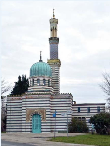
Dampfmaschinenhaus für Sanssouci, auch „Pumpenhaus“ oder „Moschee“ genannt, 1841-1843 in Potsdam errichtet.
